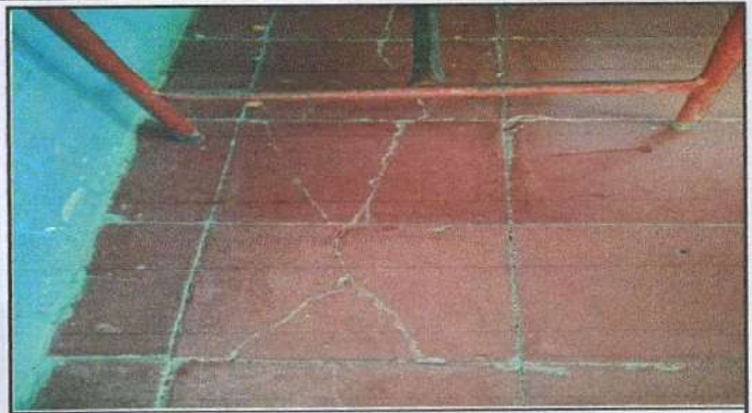
8. Sustitución de piso de granito en mal estado, por piso de granito en aulas.
