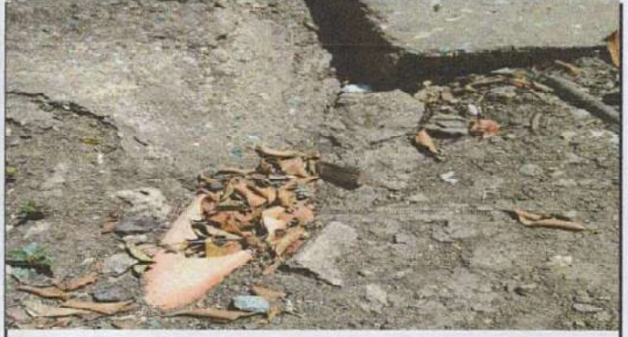
2. Sustitución de tubo de red de drenaje. Tubo de 6"
