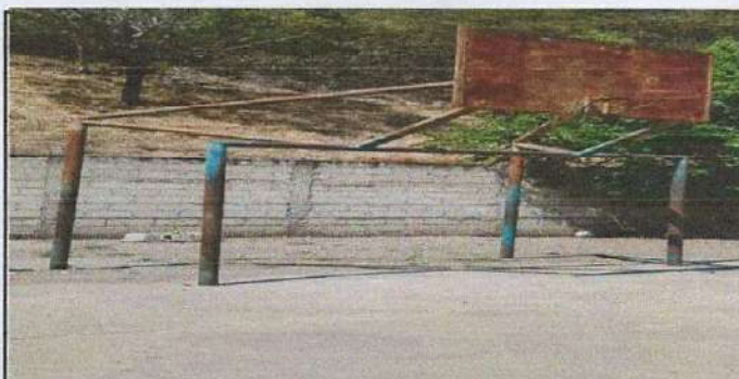
5. Reparación de porterías de cancha (lijado y pintura) medida de 3*2.50mts
