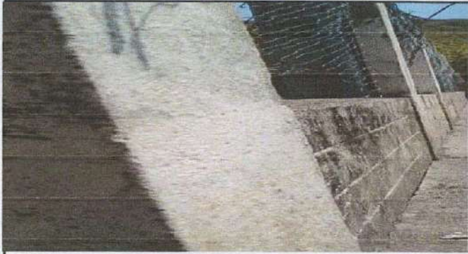
1. Reparación y refuerzo de muro perimetral de block
