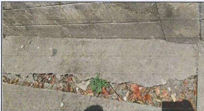
3. Sustitución de cuneta de concreto, por cuneta de concreto
