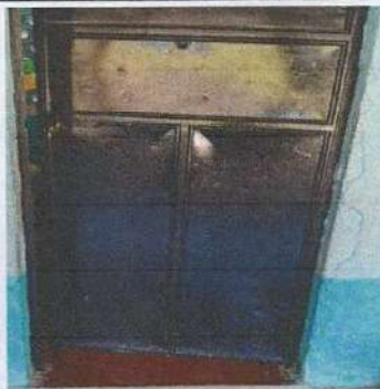
9. Sustitución de puerta de metal en mal estado, por puertas de metal medida de 1*2.15 mts.
