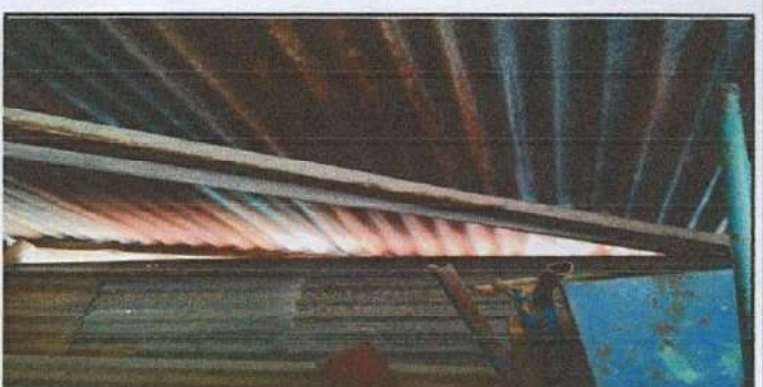
6. Sustitución de estructura de techo, por estructura galvanizada costanera de 3" y cargadores de 3*2"
